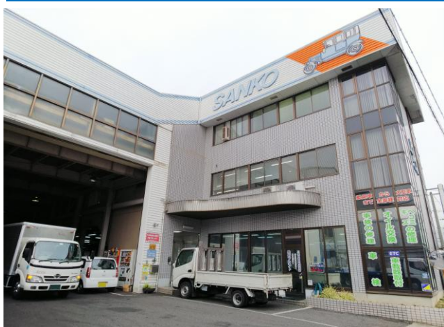
三晃自動車(株) 本社(堺) 大型車輸入車整備工場
